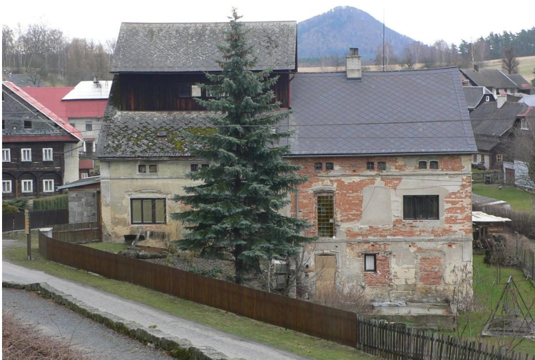
Obr. 14. Sloup čp. 82 (CL), celkový pohled na mlýn, mlýnice s bedněnou nástavbou je situována v levé části, stav před zateplením fasády. Foto M. Kolka, 2009.
