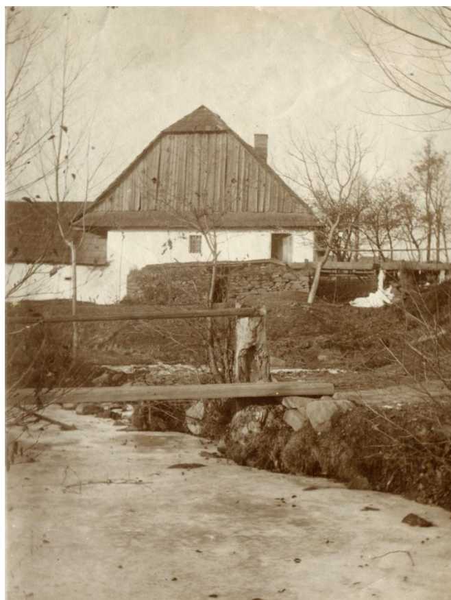
Obr. 2. Žďárec u Skutče čp. 37 (okr. Chrudim). Původní mlýn s kolem na vrchní vodu, lednice, vantroky před přestavbou roku 1926. Dobové foto, autor neznámý.
