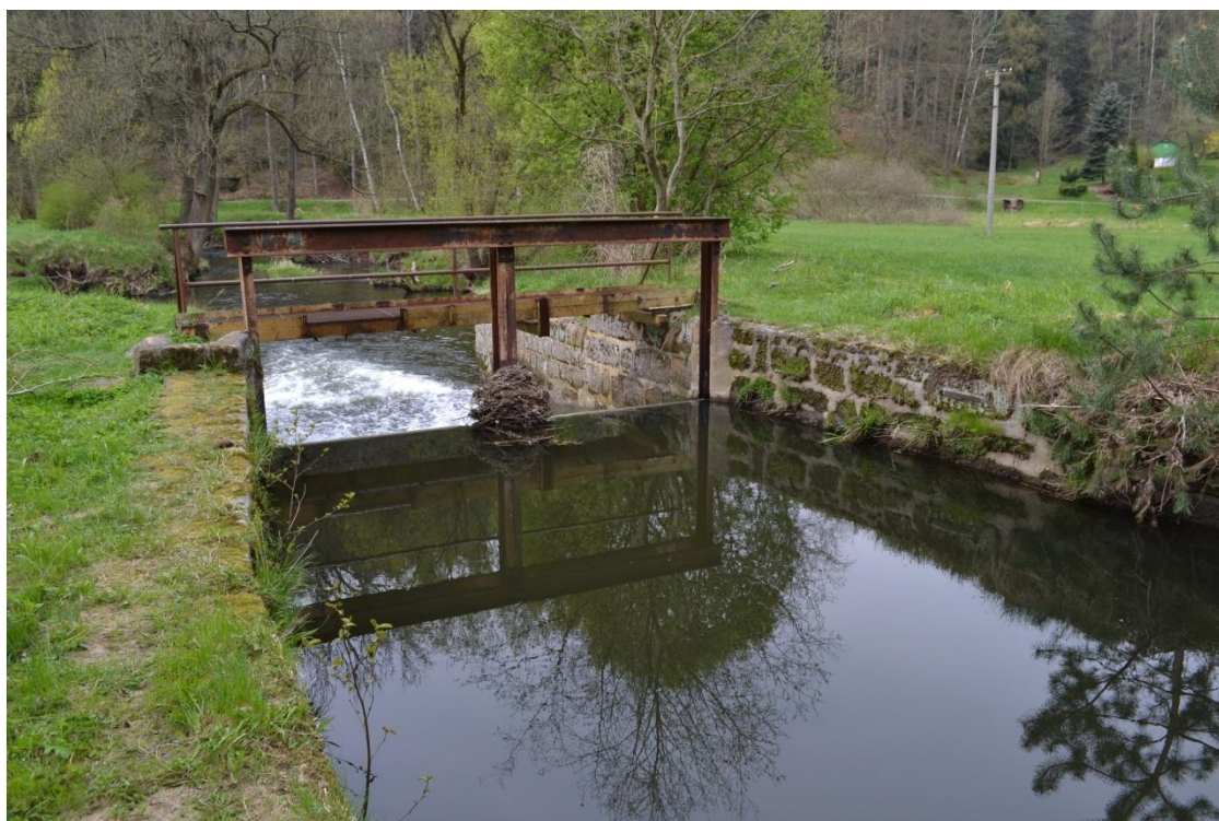
Obr. 4. Velenice čp. 20 (CL), pohled na stavidlový jez na Svitávce, na pravém břehu ve zdivu skoba vodoprávní značky, nátok náhon je na levém břehu zaslepený. Foto M. Kolka, 2017.
