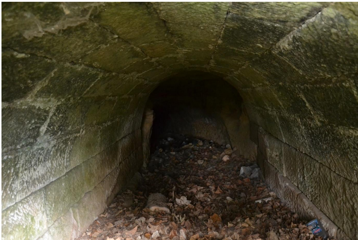
Obr. 6. Lindava čp. 87 (CL), pohled zaústění náhonu do klenuté části a následně do skalní štolky. Foto M. Kolka, 2019.
