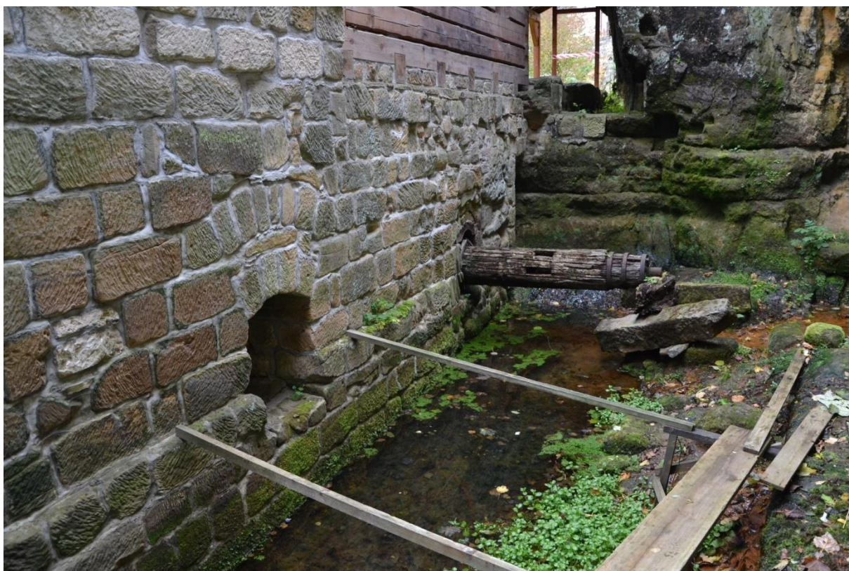
Obr. 7. Radvanec čp. 77 (CL), pohled do lednice s hřídelí vodního kola, vlevo otvor pro hřídel druhého dodatečně přidaného kola, v pozadí vyústění náhonu. Foto M. Kolka, 2019.
