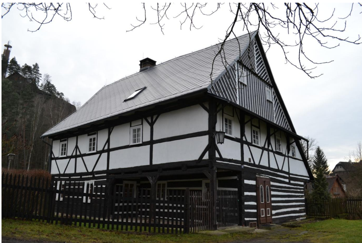
Obr. 11. Sloup čp. 117 (CL), celkový pohled na mlýn s roubeným přízemím a hrázděným patrem, v čele podsíň, za ní je situovaná mlýnice. Foto M. Kolka, 2014.
