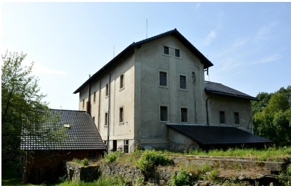
Obr. 4. Žďárec u Skutče čp. 37 (okr. Chrudim). Mlýn s přístavbou obytné části (čp. 50 vlevo), betonovým náhonem s lednicí, v pultovém přístavku je umístěn elektrický motor. Foto M. Křivanová, 2017.
