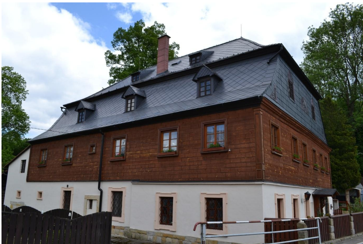
Obr. 10. Skalice čp. 269 (CL), celkový pohled na mlýn se zděným přízemím a roubeným patrem. Foto M. Kolka, 2017.
