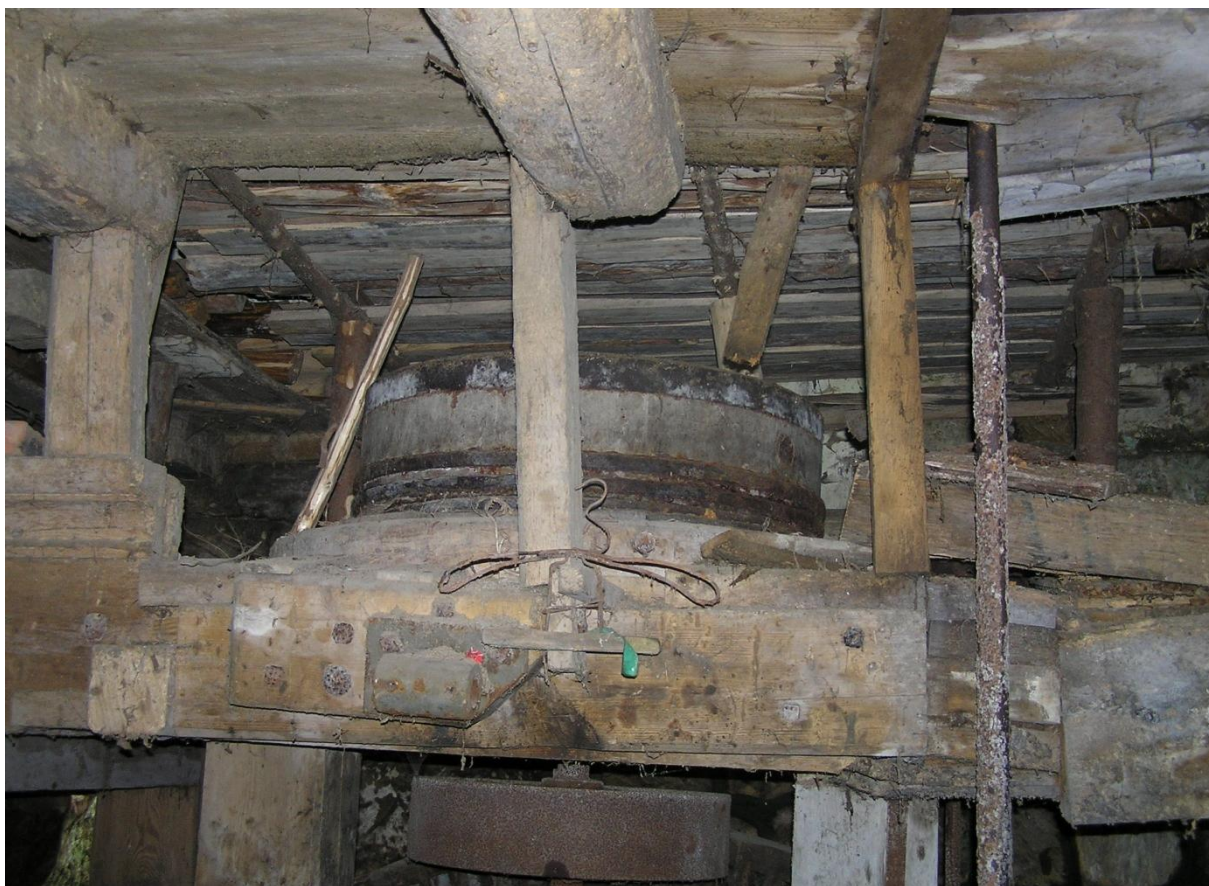
Obr. 17. Radvanec čp. 77 (CL), pohled na zaniklou mlýnskou hranici s železím a mlecím složením. Foto M. Kolka, 2005.
