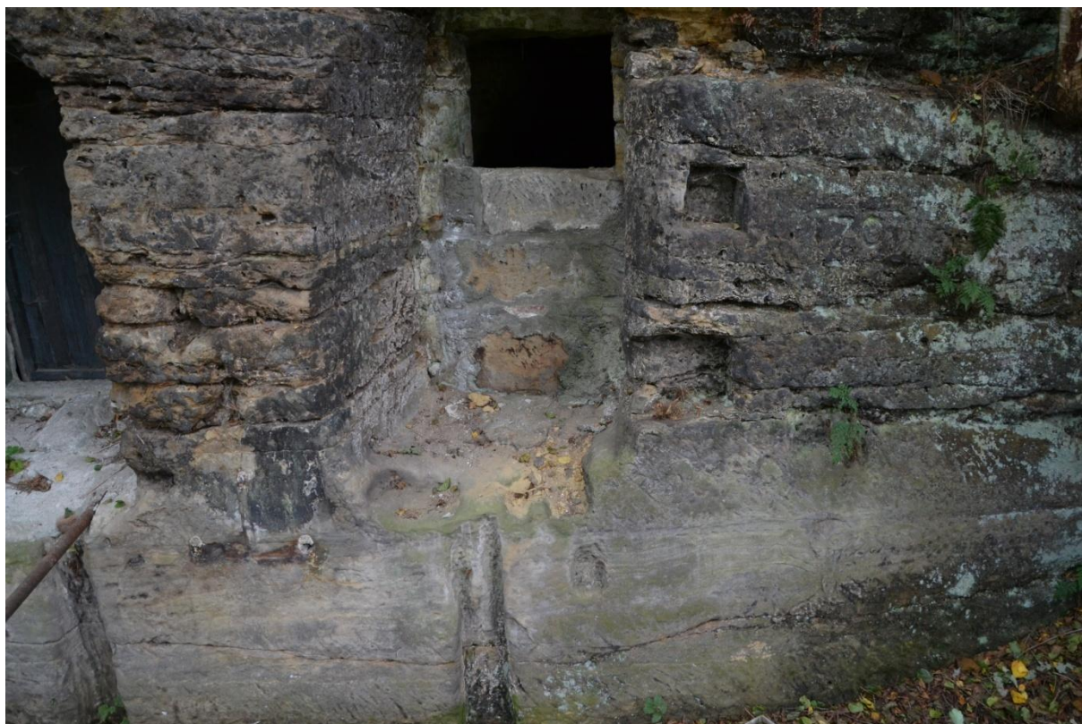
Obr. 8. Radvanec čp. 77 (CL), pohled na skalní stěnu nad jalovým přepadem pod nádrží, dráže pro stavidla, na pilíři vlevo otisk skoby vodopravní značky, nad ní trojúhelník s ryskou, vpravo datace 1701. Foto M. Kolka, 2019.
