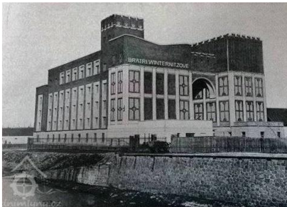
Obr. 3. Pardubice čp. 436, mlýny Bratři Winternitzové po dostavbě v roce 1924. Reprodukce fotografie z časopisu Stavba 1923/24, 1911–12, Josef Gočár. Zdroj: http://vodnimlyny.cz/en/mlyny/estates/detail/2144-winternitzovy-mlyny#tab-photogallery .
