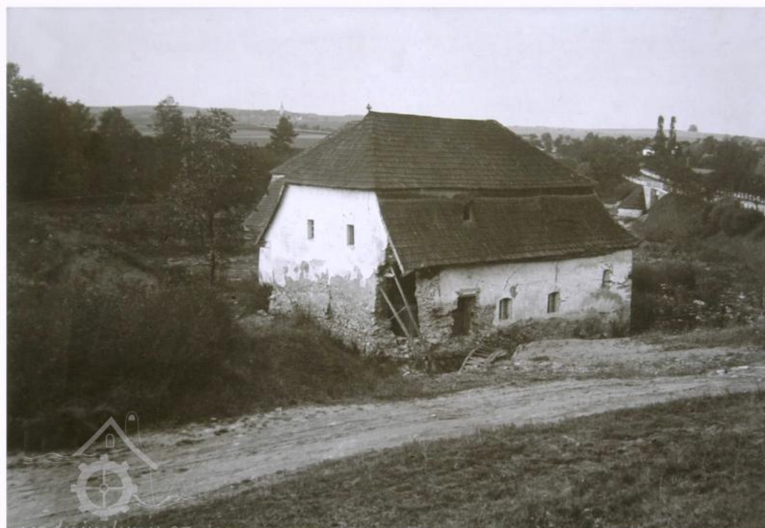
Obr. 7. Těžce poškozený Smykovský mlýn 17. 6. 1906.
