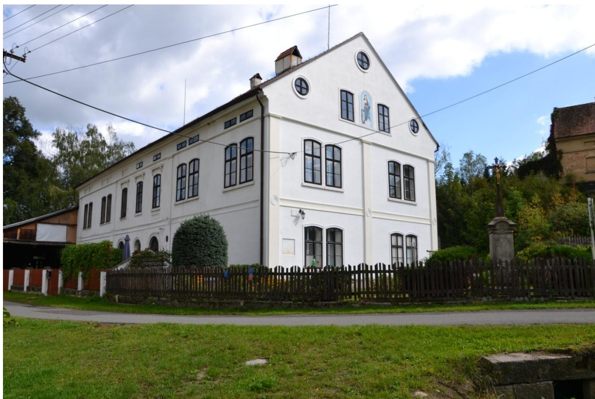
Obr. 13. Lindava čp. 87 (CL), celkový pohled na mlýn od vyústění odtokového kanálu. Foto M. Kolka, 2019.
